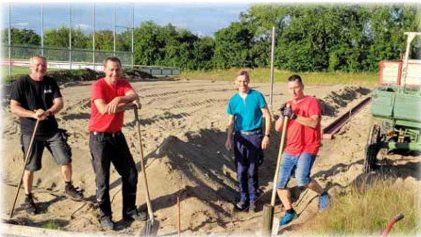
Viel Handarbeit: Für die Rand- und Mähkantensteine musste viel mit Schüppe und Harke gearbeitet werden
