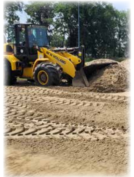
Die großen Mengen wurden zunächst vom Lohnunternehmen Arno Schmitz in die Grube gefahren, dann durch Gala-Bauer Francis Kern verteilt, bevor anschließend mit einem Nivelliergerät vom Gartenbaubetrieb Boes-Nehnes die Feinverteilung vorgenommen werden konnte
